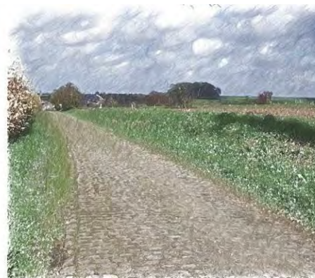
Route pavée à Troisvilles
