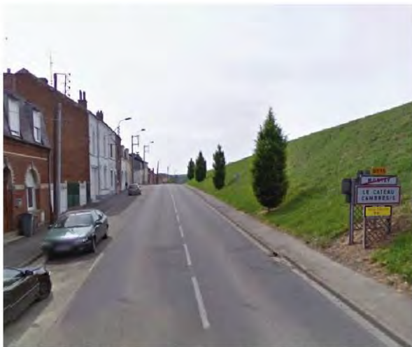
3 - Entrée Nord. Tissu urbain de Montay et du Cateau-Cambrésis jointifs au niveau du panneau d'entrée.
