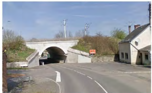
5b - L'entrée véritable par la D12 est marquée par le franchissement sous le pont de la voie ferrée. Il constitue une porte de la ville.
