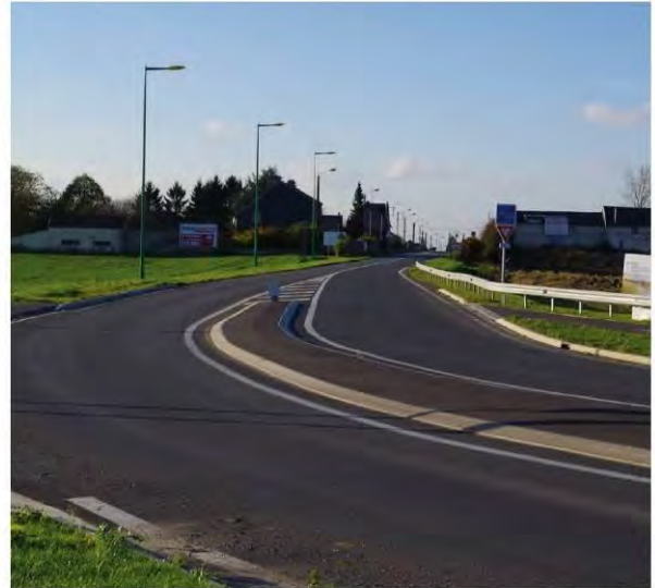
2 - Entrée Est par la D643. Sur le plateau puis en pente. La construction en cours de la voie de contournement Nord évitera les problèmes de sécurité.
