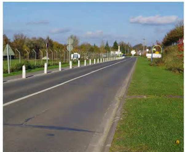
4 - Entrée Sud-Ouest par la D21. Arrivée dans la vallée de la Selle. Point focal de l'église St-Martin visible avant l'entrée de ville. Giratoire sécurisant l'entrée.
