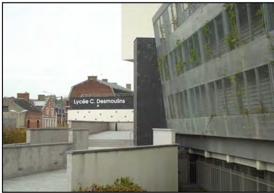
Lycée Camille Desmoulins
