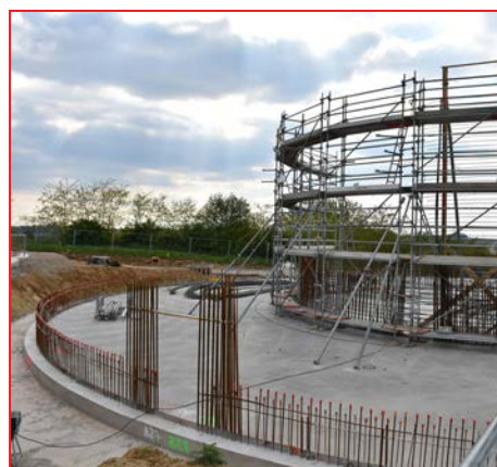
L'armature du bassin d'aération de 5 000 m 3 destiné à récolter les diverses eaux.
