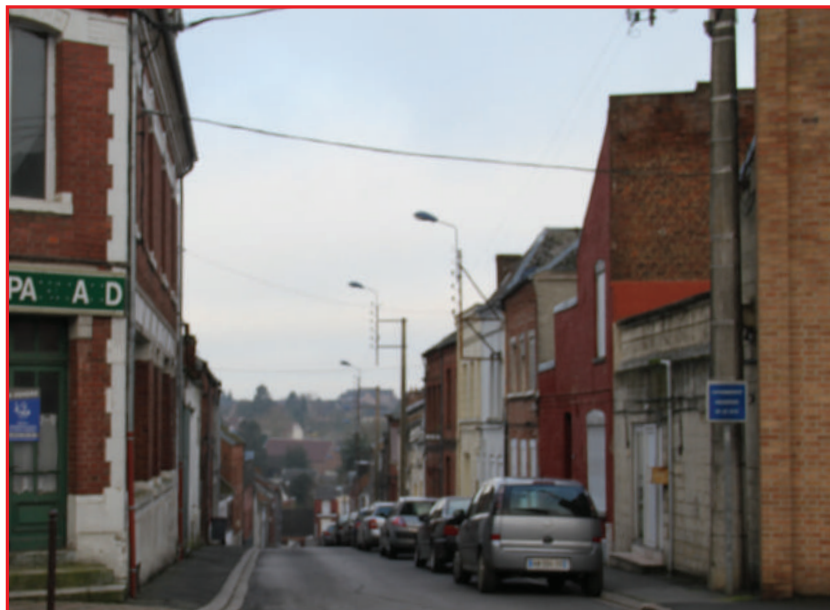
Rue Louis Carlier Un vaste chantier d'avril à octobre
