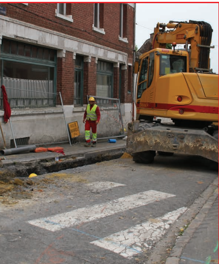
Encore quelques mois de travaux, mais à terme, la rue Louis Carlier sera totalement rénovée.
