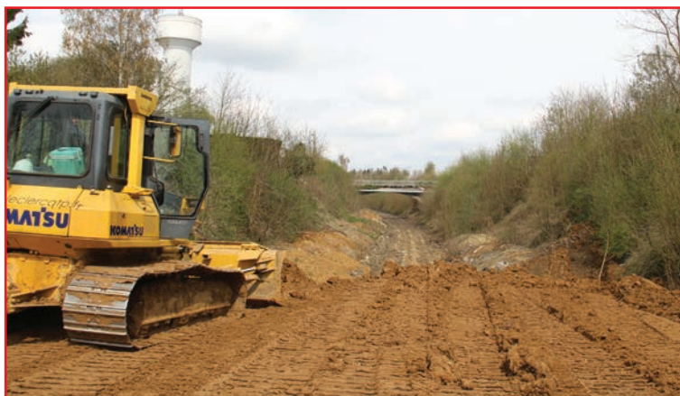
Chemin de randonnée Des terres pour préparer l'aménagement des chemins prévu pour 2019
