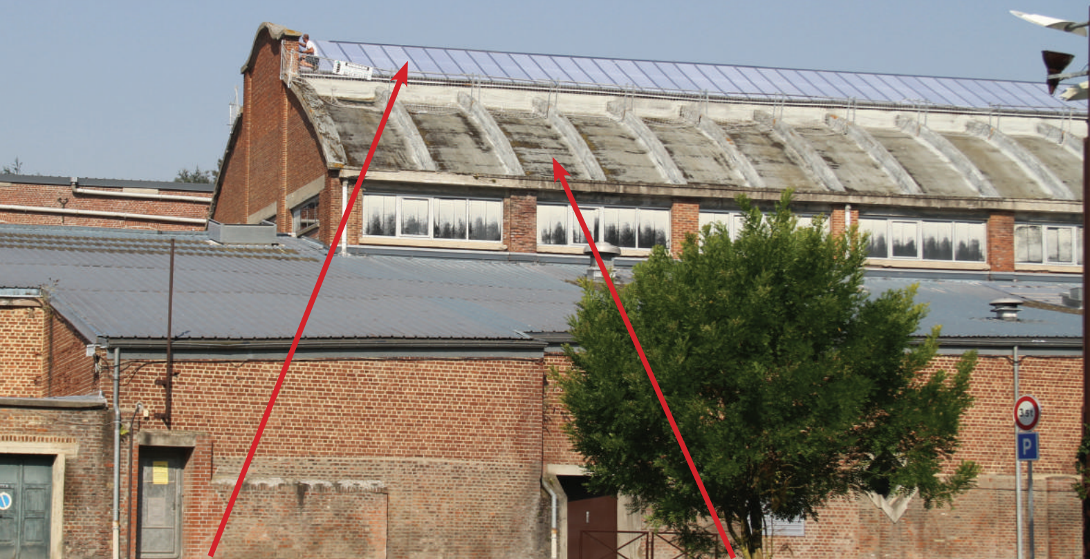
Pendant l'été la verrière a été entièrement rénovée. A suivre, la réfection complète de la toiture
